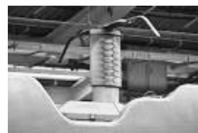
新幹線のパンタグラフ
